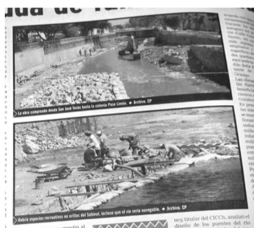
Trabajos sobre el río Sabinal. Archivo CP
